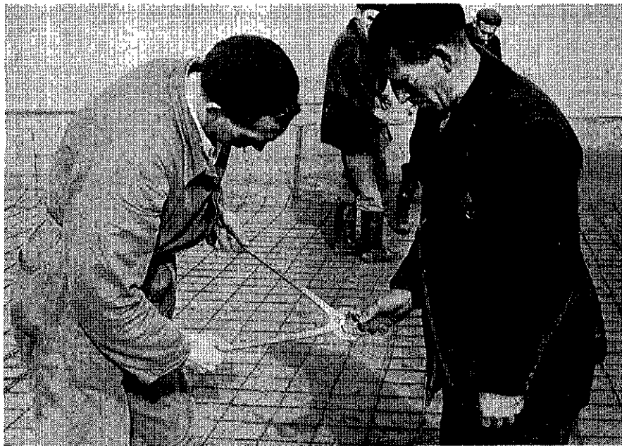
2. Aanbrengen van de schalmen
