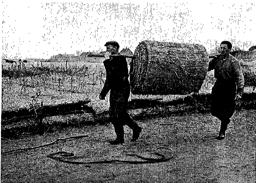
3. Aanvoer van de geperste rietmatten
